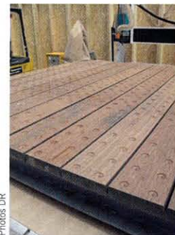
CHEMIN GARANTI 1-Bande de guidage inox. 2-Éléments antidérapants traits/points. 3-Dalle en ipé.
