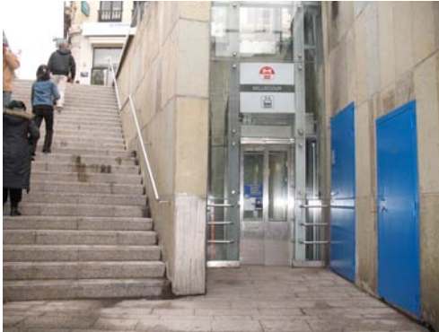
Ascenseur Métro Bellecour
